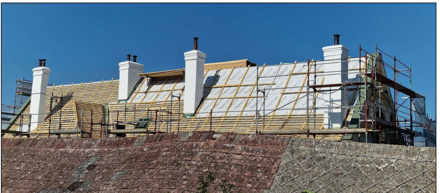
^ sanierte Kamine mit erneuerten Kaminaufsätzen
