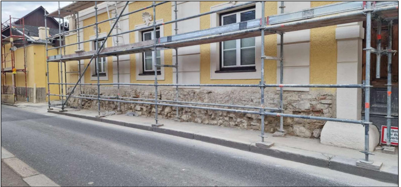
^ bis auf das Mauerwerk abgetragener Sockelputz
