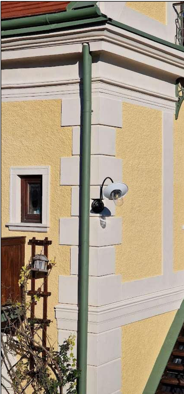
^ Gebäudekante Innenhof-Giebel- seite mit restaurierter Hof-Lampe
