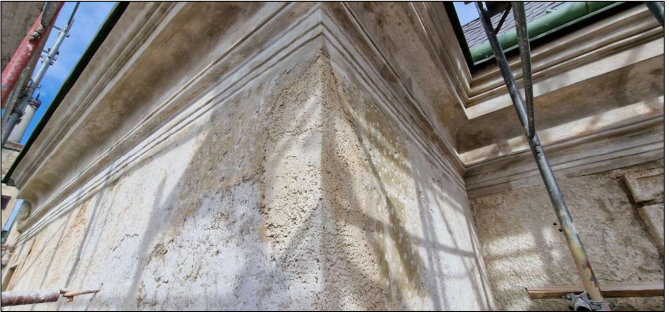
^ Innenhof: nach der Freilegung und Anlegen des Grundputz bei Fehlstellen
