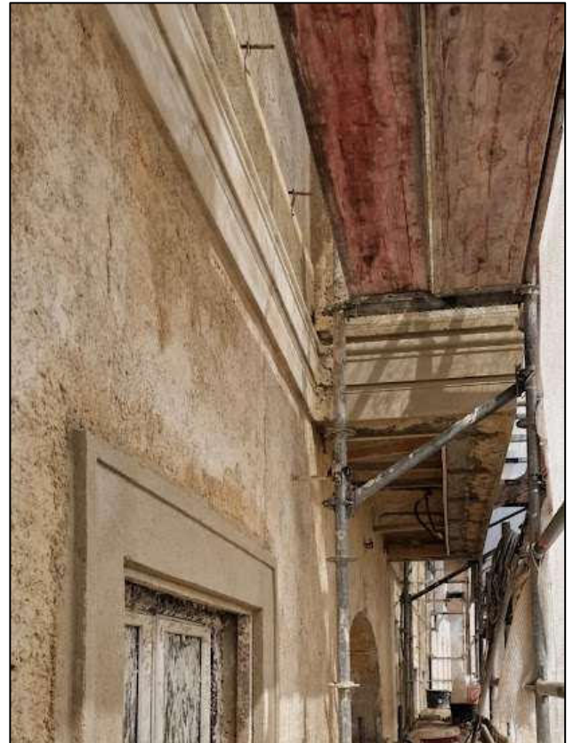
^ Zwischengesimse: Neuherstellung mit Zugschlitten
