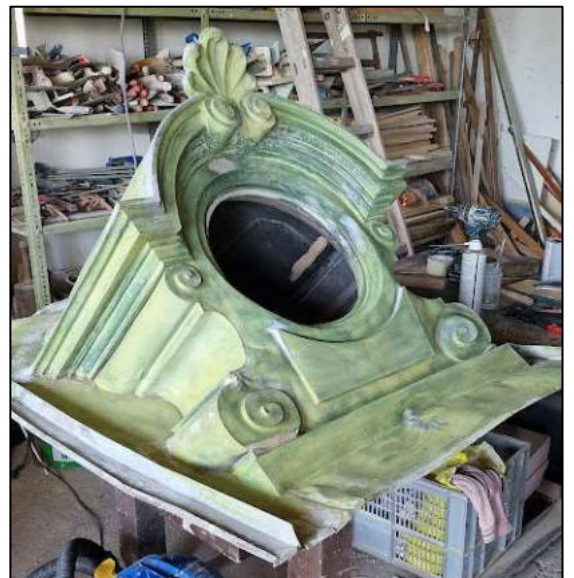
Bekrönung: ^ Reparatur durch Einsetzen (nieten) von Metallflicken; abschließende Beschichtung
