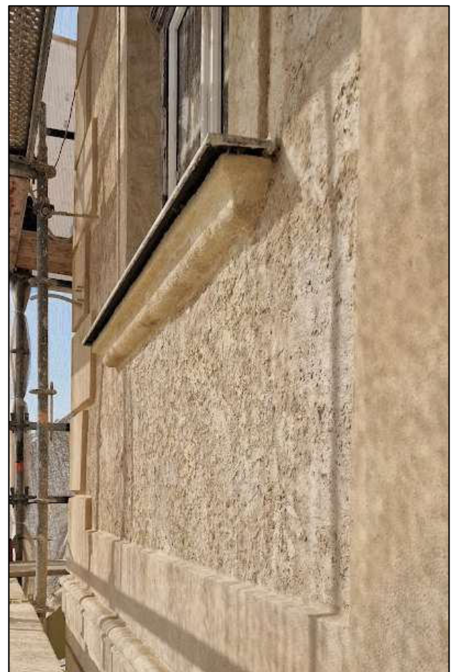
^ Fensterparapet im OG: freigelegt und gereinigt
