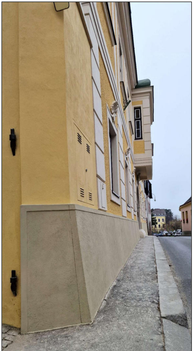
^ Sockelzone mit Randschlag und Fugenschnitt
