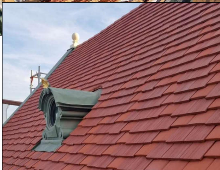
Detailansicht mit restaurierter Gaube >
