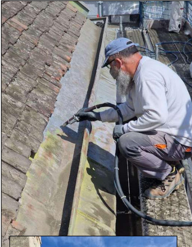
^ Bekrönung: Mitarbeiter bei der Sanierung < Sandstrahlen der Saumbleche und Rinnen
