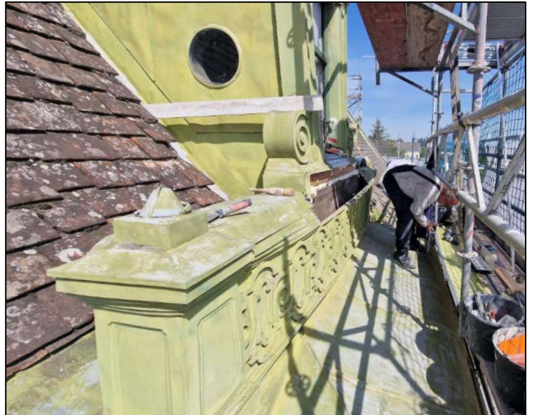
^ Bekrönung: Mitarbeiter bei der Sanierung < Sandstrahlen der Saumbleche und Rinnen
