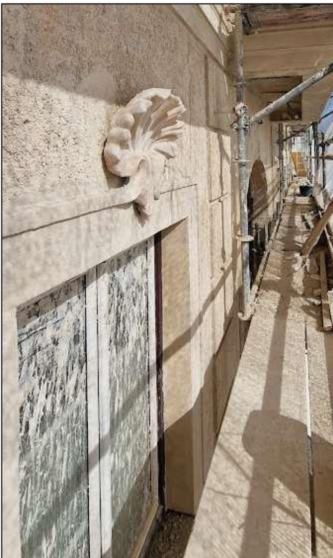
< restaurierte Fensterlaibung im Erdgeschoss mit Muschel-Applikation (Kunststeinguss)
