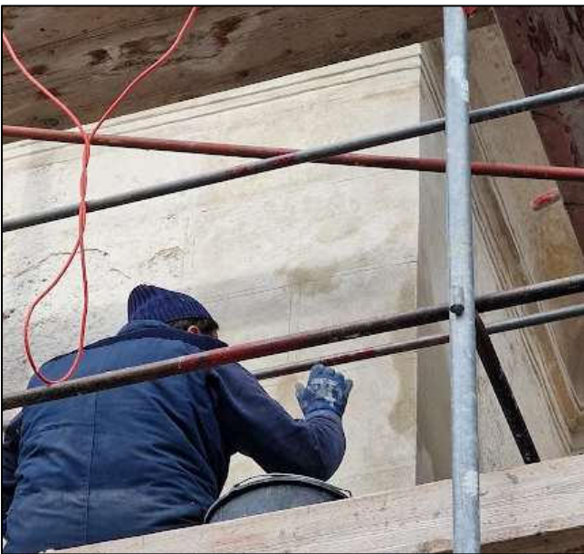
^ Innenhof: nach der Freilegung und Anlegen des Grundputz bei Fehlstellen
