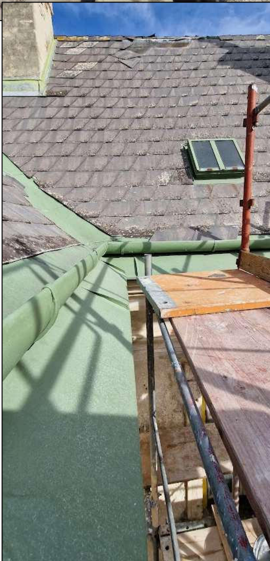
Bekrönung: ^ Reparatur durch Einsetzen (nieten) von Metallflicken; abschließende Beschichtung
