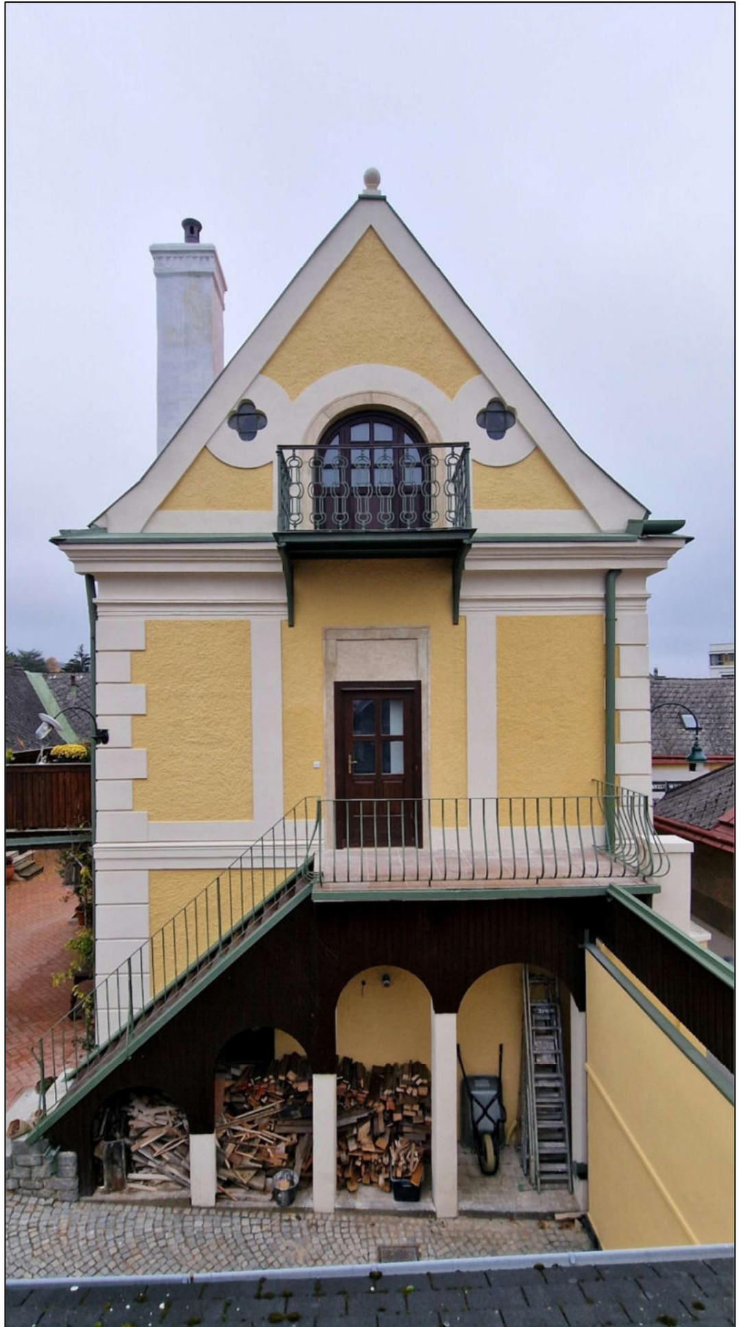
Giebelseite nach der Restaurierung
