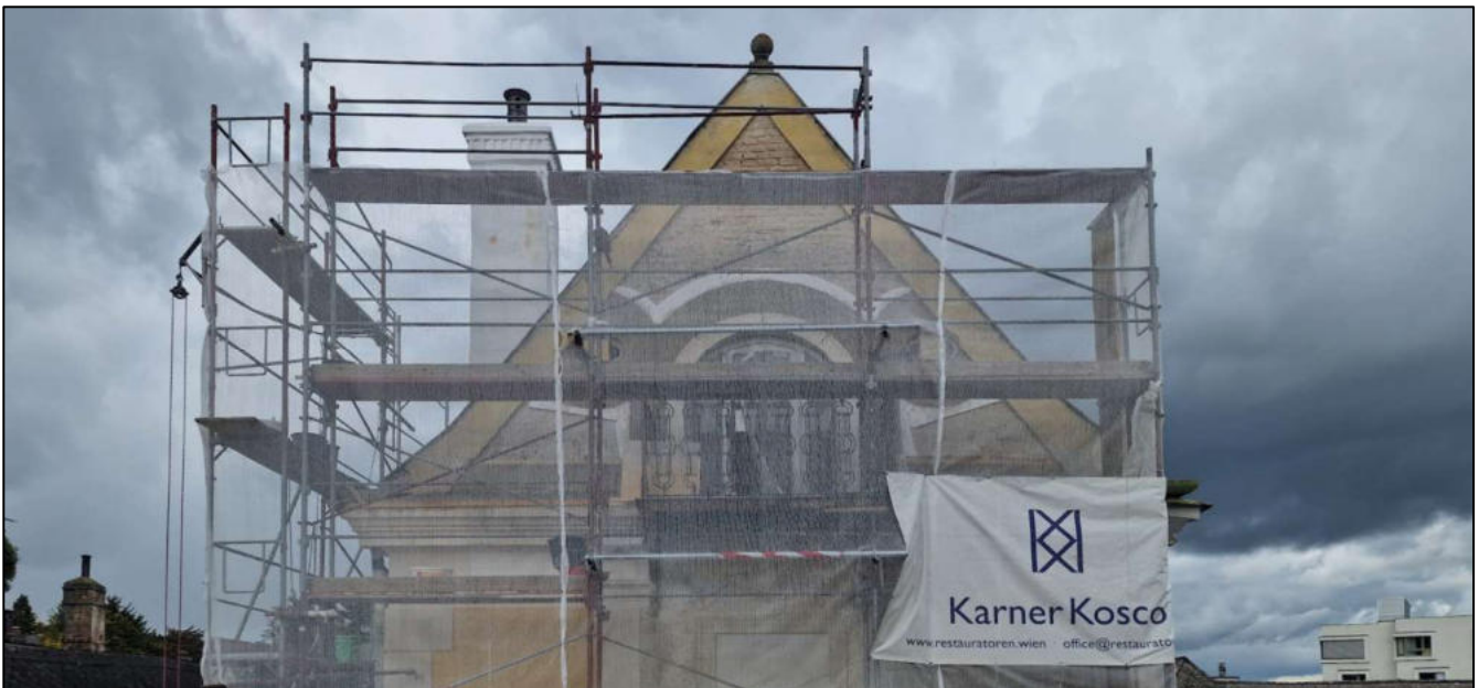
Südliche Giebelseite: Neuerstellung der verlorenen Putzgliederung; Restaurierung der Steinlaibung
