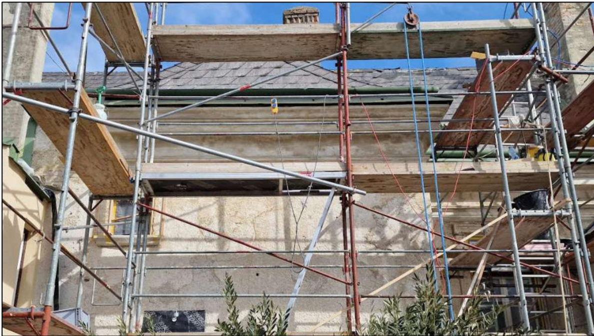
Innenhof: Ansichten nach der Freilegung der ursprünglichen Putzebene (Rieselputz; Steingewände, Hauptgesimse)
