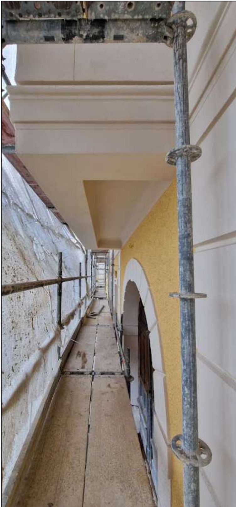
^ Außenfassade: Zwischengesimse beim auskragenden Erker; neu hergestellte Quader im Portalbogen
