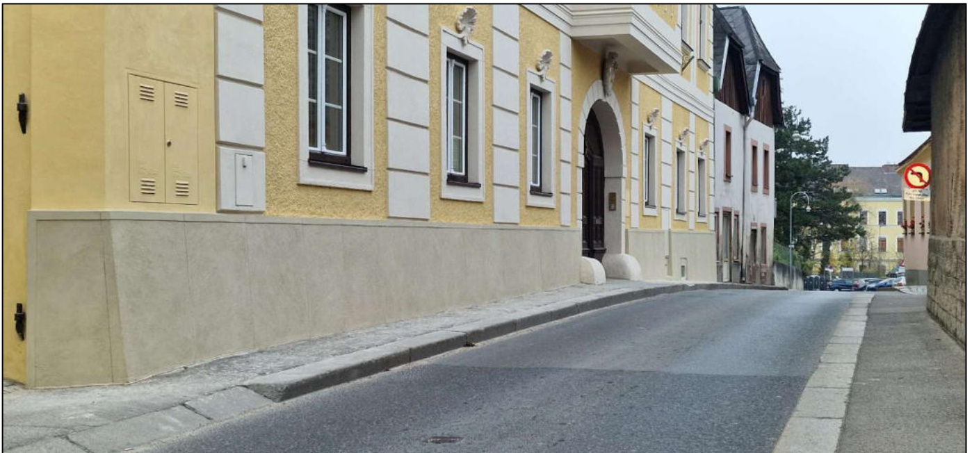
^ Sockelzone nach der Fertigstellung
