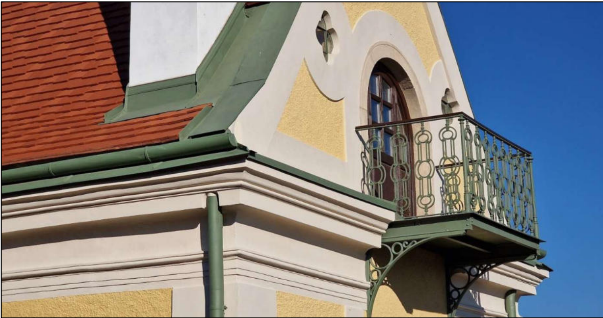
^ Südliche Giebelseite: Hauptgesimse, Giebelgestaltung, Metalle (Bleche und Balkon)
